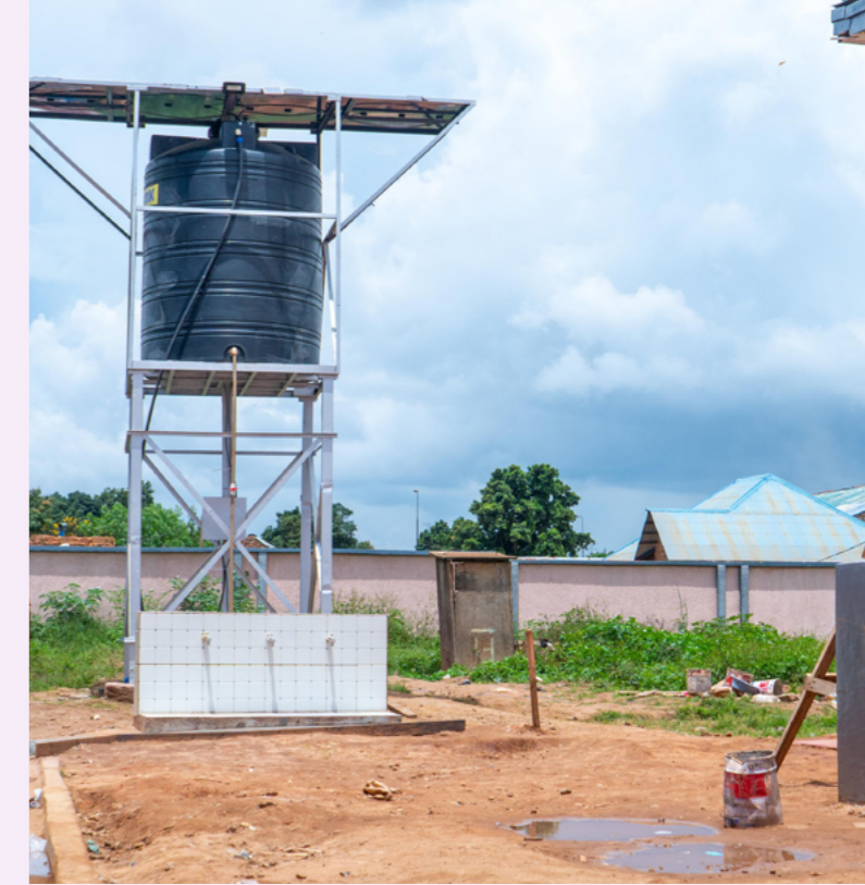
Forage d'un puits à l'école primaire de Dima.
